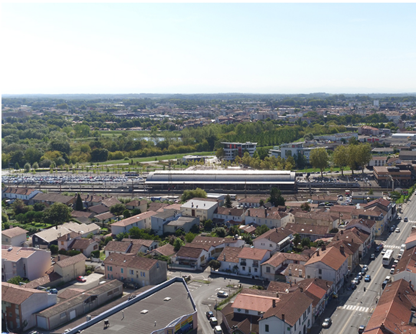
Siège du Grand Dax, 15 avenue de la gare
