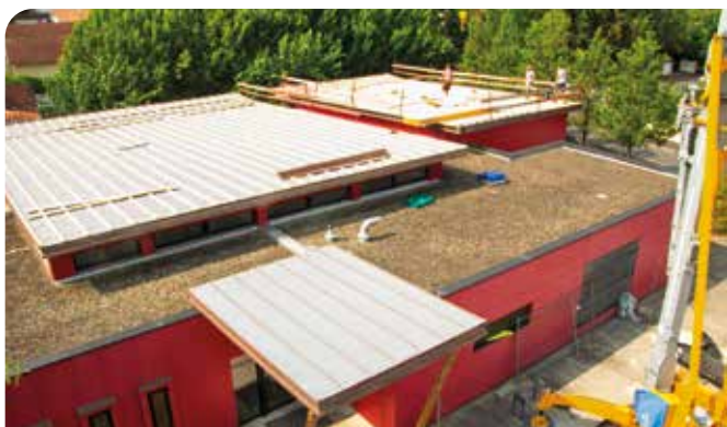
Entièrement reprise durant l'été, la toiture du Multiaccueil François Dolto bénéficie désormais d'une meilleure étanchéité et d'une isolation renforcée. Les ultimes travaux se termineront en septembre, garantissant un cadre plus confortable pour petits et grands.
