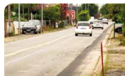
Réalisation de la piste cyclable avenue Pierre Benoît
