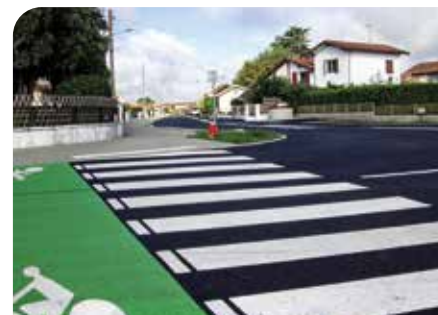
L'aménagement de la voirie structurant rue Gilbert Lahillade avec l'Agglomération du Grand Dax.
